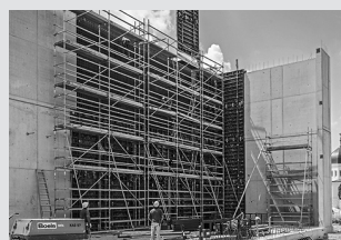
Скелета за достъп до конструкции
